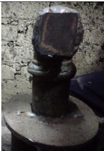
**Foto No. 5. Lámina soldada en boca del pozo**
